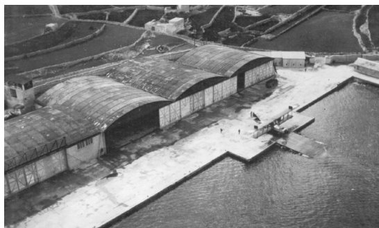
Hangar de la Base RAF de Kalafrana (atchistory.wordpress.com)
