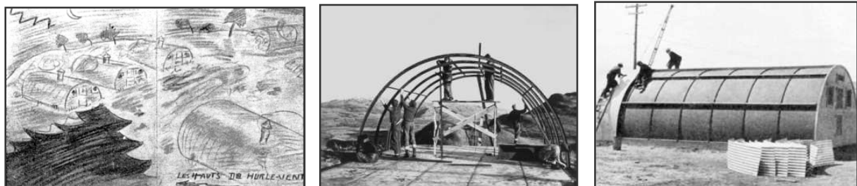
Construction des baraquements (Archives AMFAFL)
